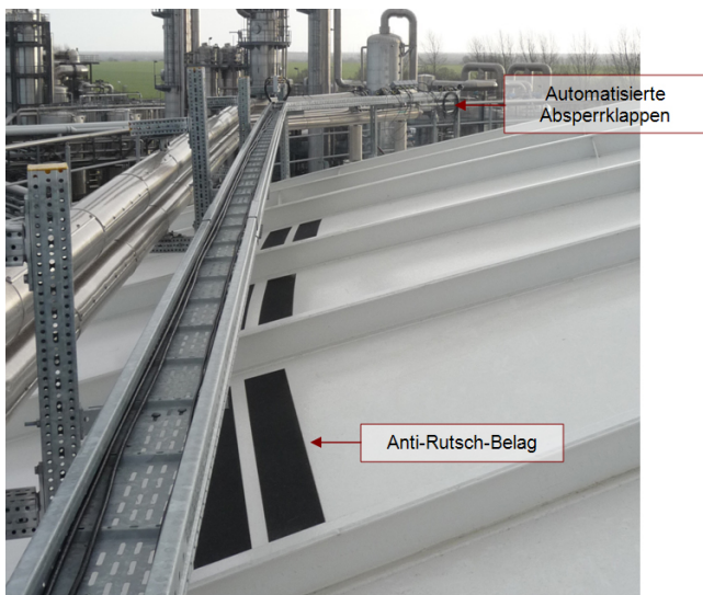
Abb. 2: Tankoberseite mit bereits installiertem Kabelkanal
