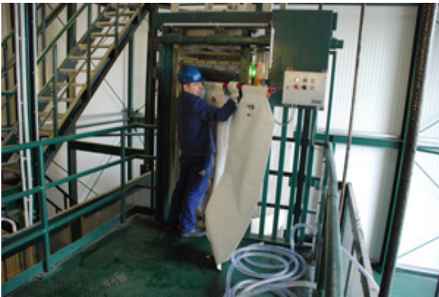
Einhängen der Wasserbehälter
