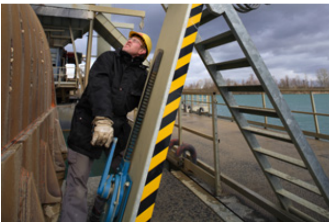
Ausrichten der Treppenleiter
