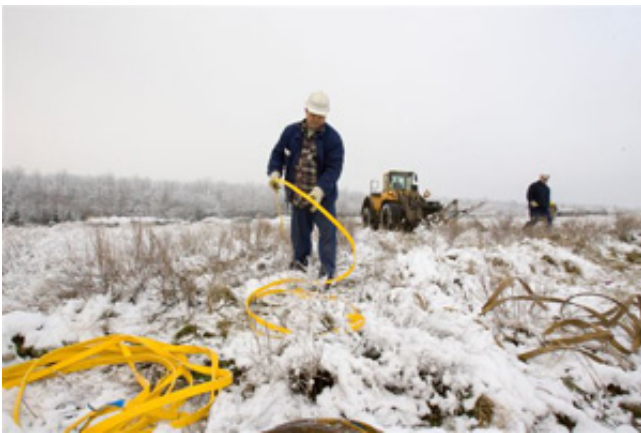
Arbeiten am Zugseil
