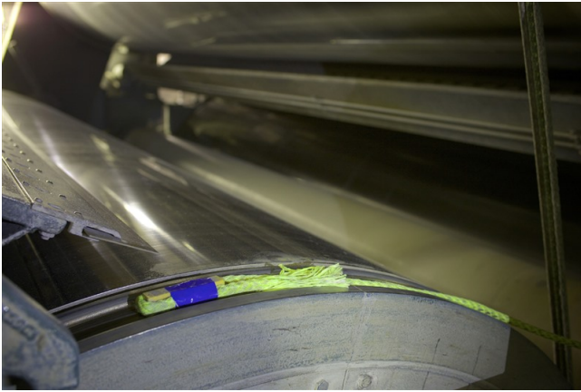
Auflegen des Aufführseils auf den Zylinder
