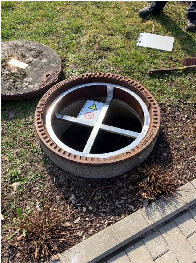
Eingelegter Schachteinsatz im laufenden Betrieb
