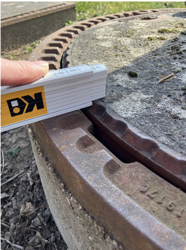
Darstellung der maximalen Deckelanhebung von 2 mm
