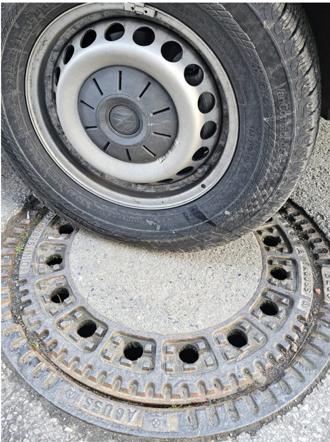
Ansicht des Zugangs zum Brunnenschacht VOR der Umbaumaßnahme
